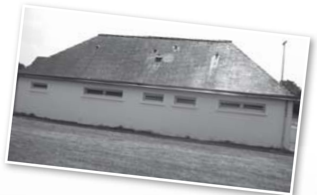
Après rénovation de peinture
