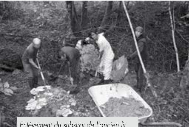
Enlèvement du substrat de l'ancien lit.
