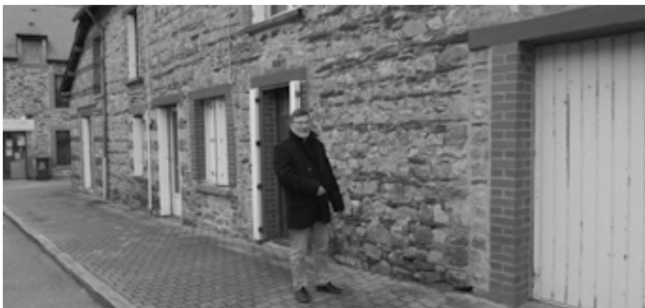
*Bâtiment municipal à rénover
